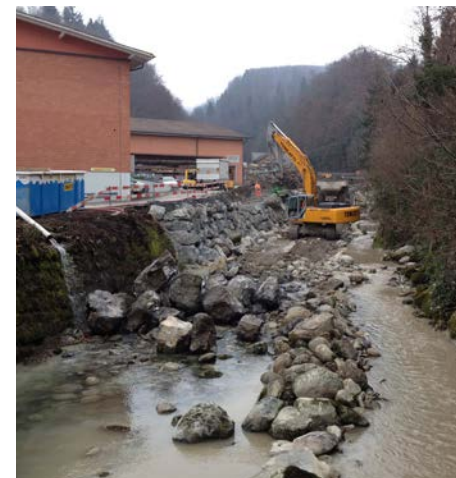
Ersatz einer Ufersicherung
